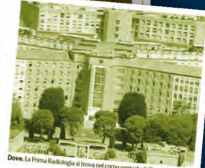
Dove. La Prima Radiologia si trova nel corpo centrale dell'ospedale
